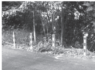
图2 临时性防护(警示桩)
